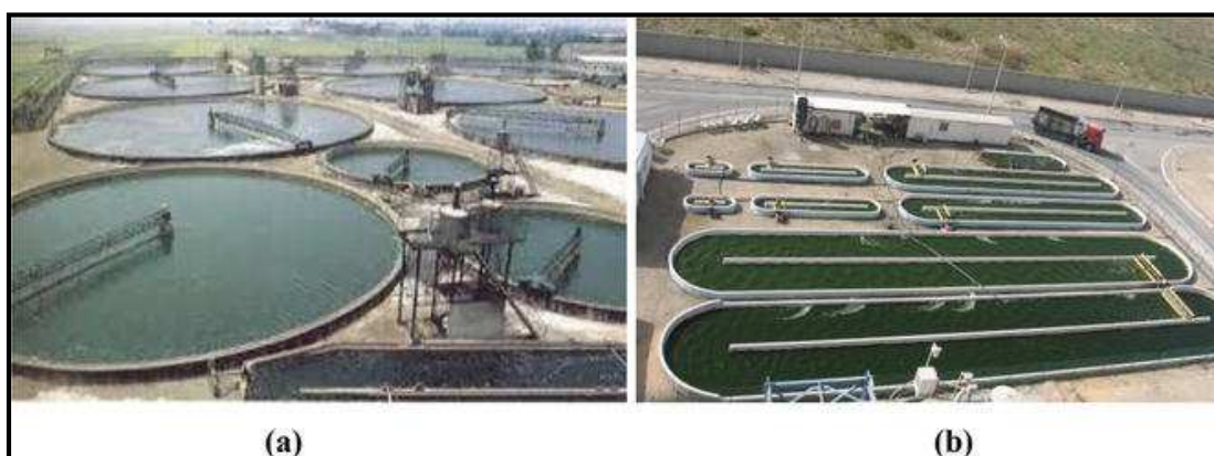
شکل ۶- سیستم‌های کشت روباز ریز جلبک‌ها (a) استخر روباز دایره‌ای (b) استخر مستطیلی
