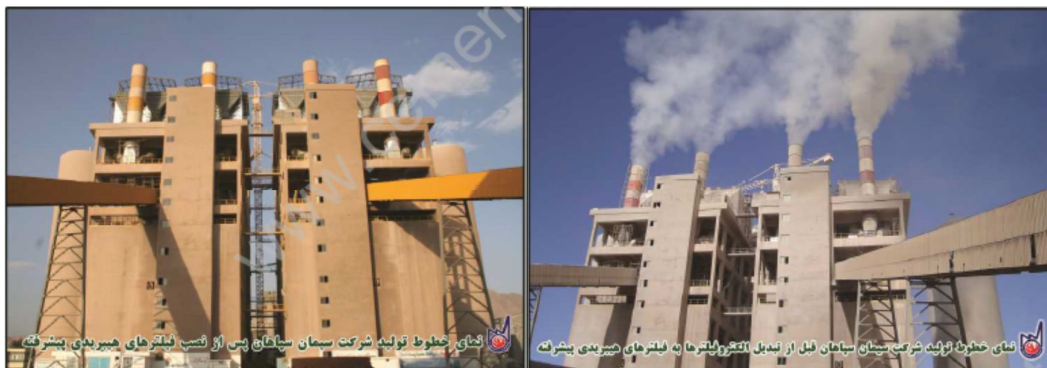
شکل (۳): نمای خط تولید شرکت سیمان سپاهان قبل و بعد از تبدیل الکتروفیلتر به فیلترهای هیبریدی [۸]
